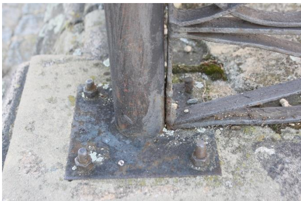
Ukotvení sloupku do země
