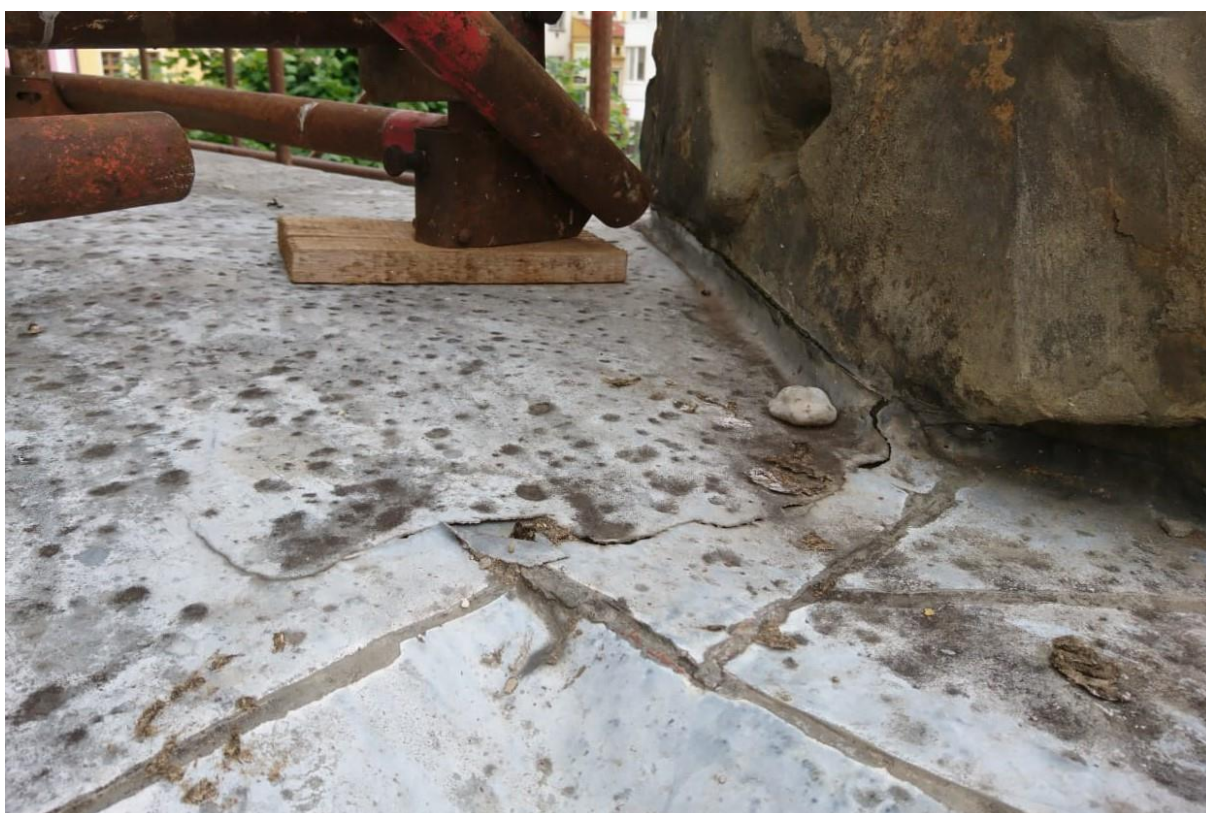
Trhlina v oplechování u plintu sochy sv. Rocha
