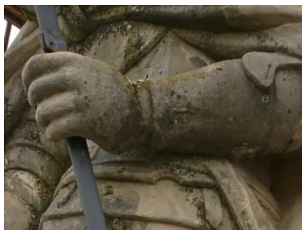
Rekonstrukce v umělém kameni
