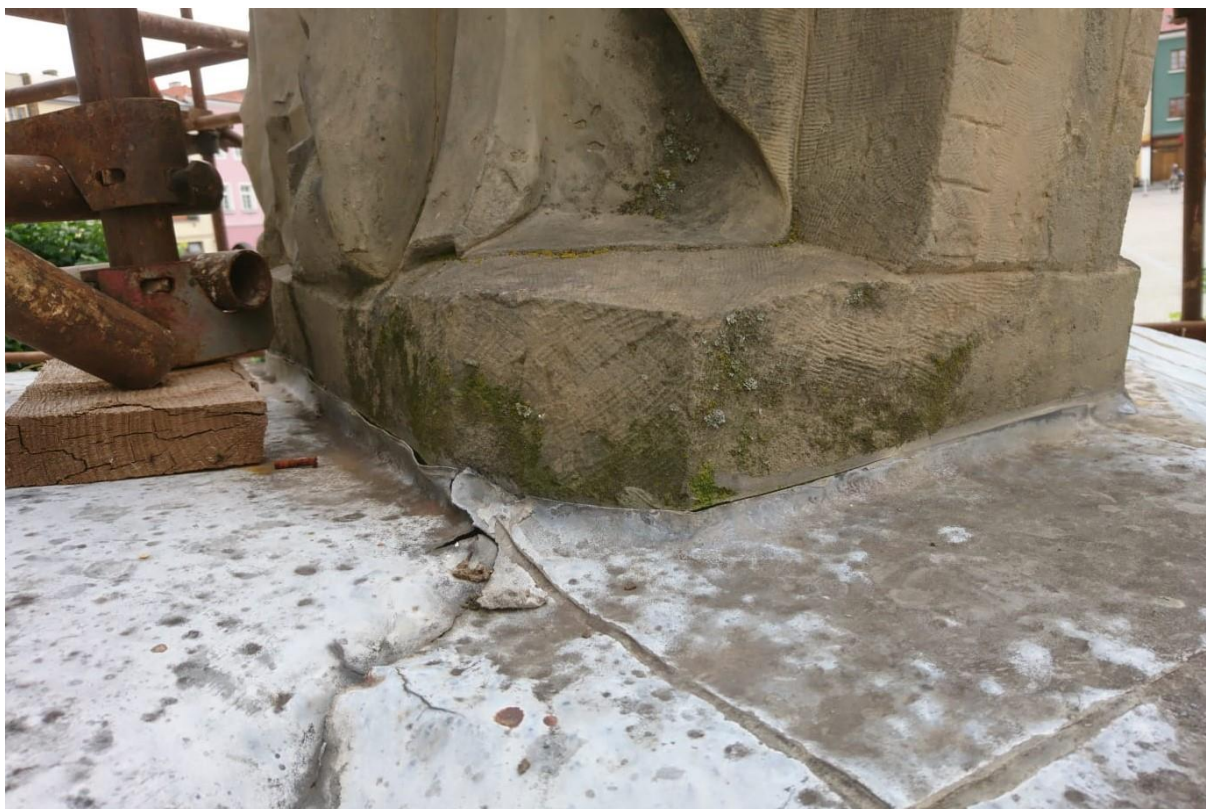
Trhlina v oplechování u plintu sochy sv. Rocha
