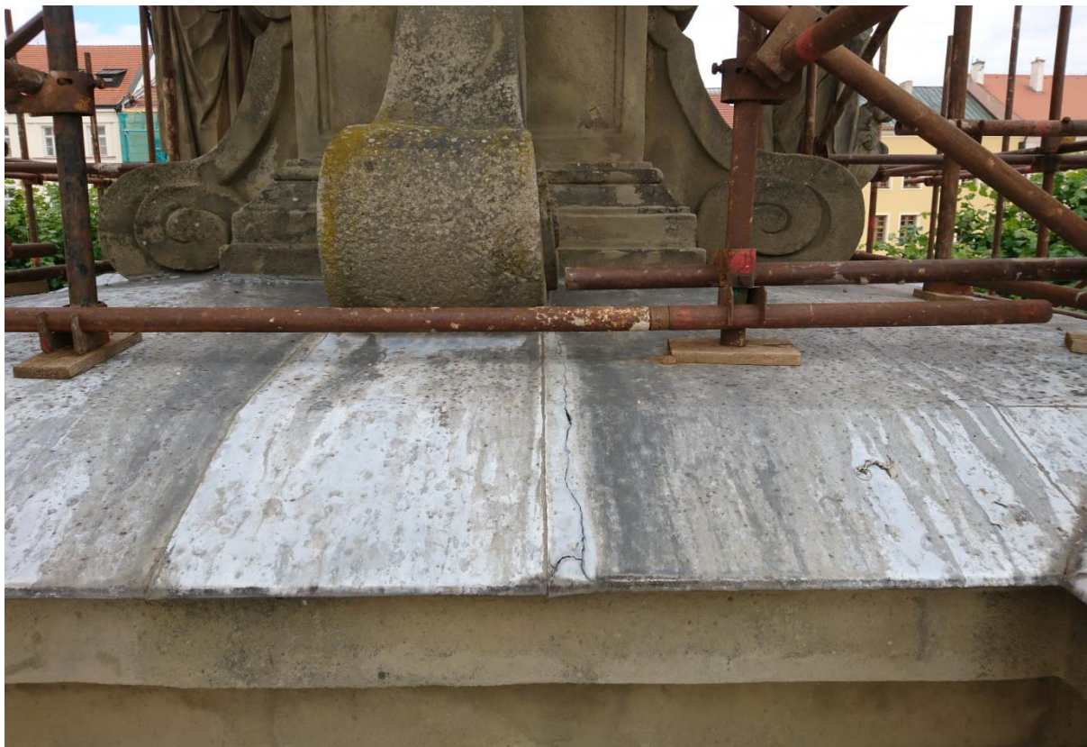
Trhlina v oplechování na pohledově levé straně
