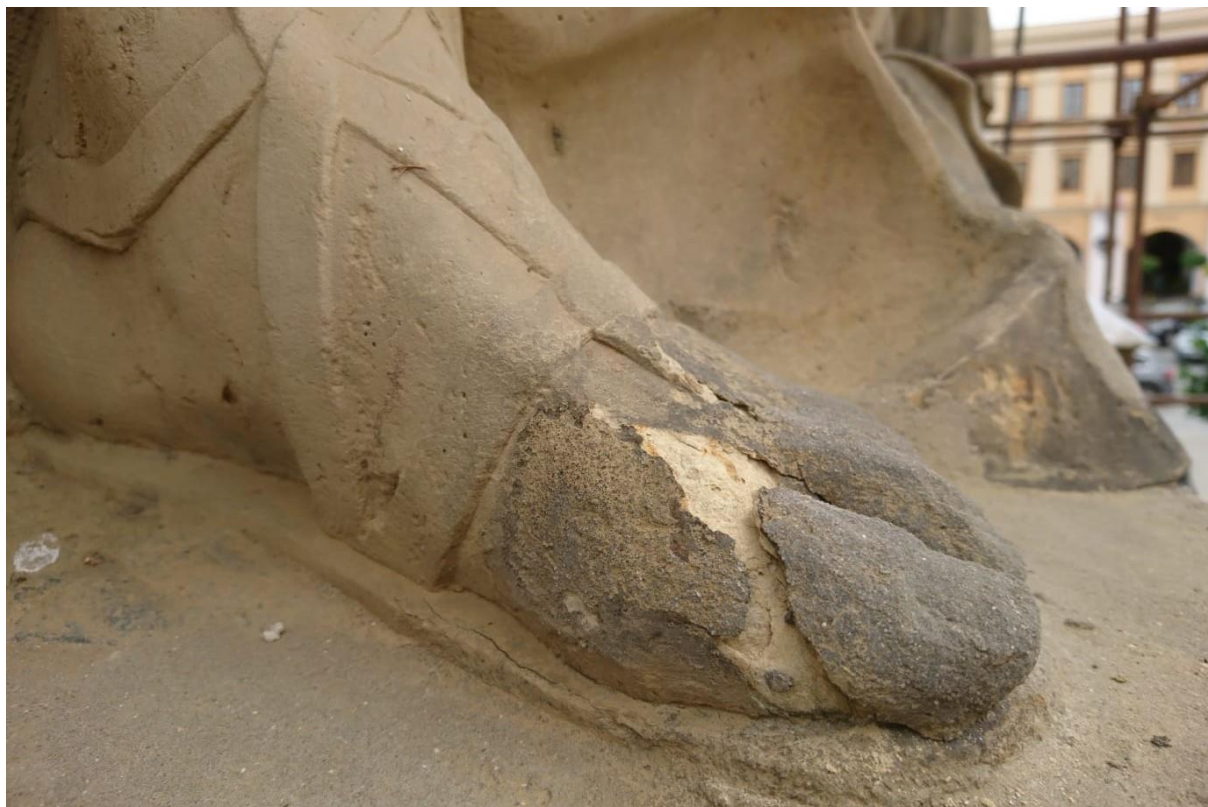
Poškozená hmota kamene v místě doplňku
