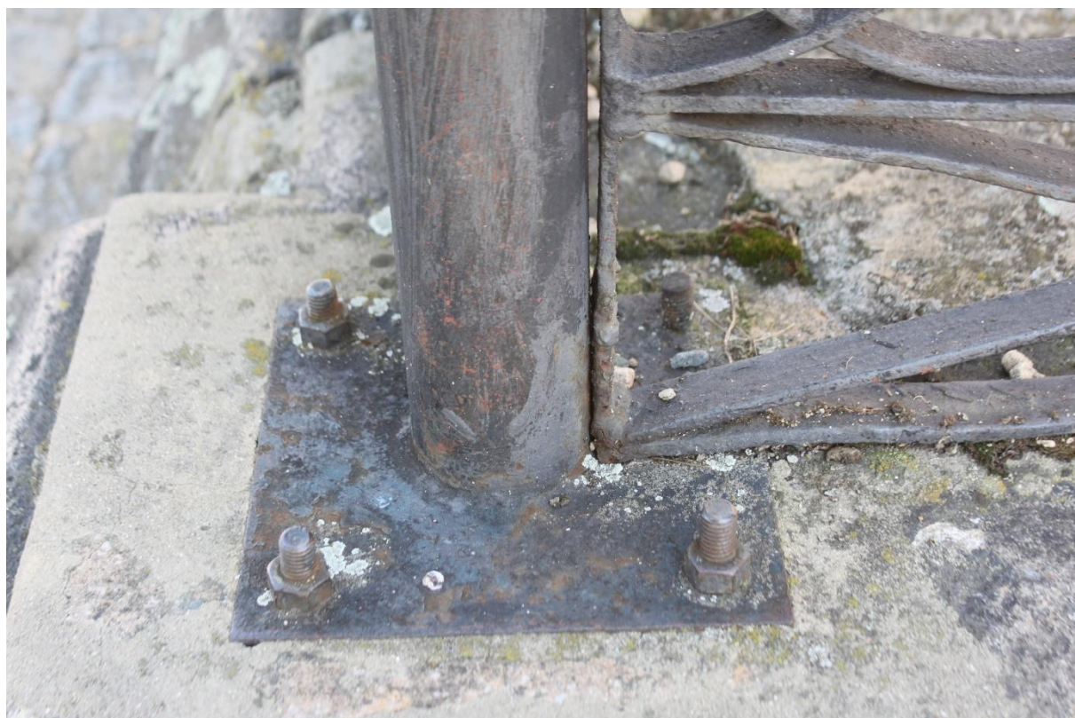
Oplocení- ukotvení sloupků
