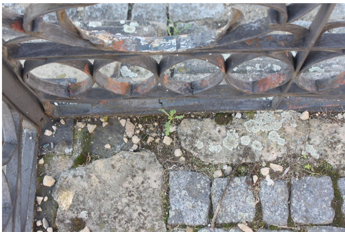
Oplocení – pohled zvenku a zevnitř
