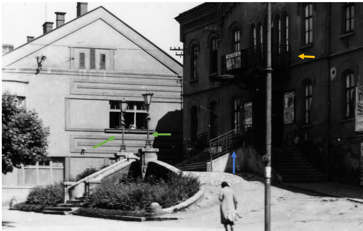
1935 detail – viz výše původní balkón nad vstupem (žlutá šipka), kovové zábradlí (modrá šipka). Na fotografii rovněž dobová svítidla (zelená šipka)
