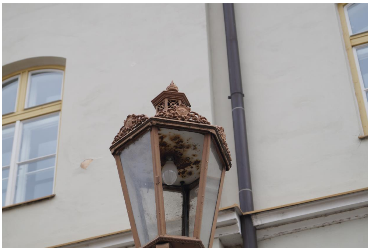
Celkový pohled na horní část lampy s ozdobnými trojúhelníkovými štíty s erby města a malou lucernou ve vrcholu
