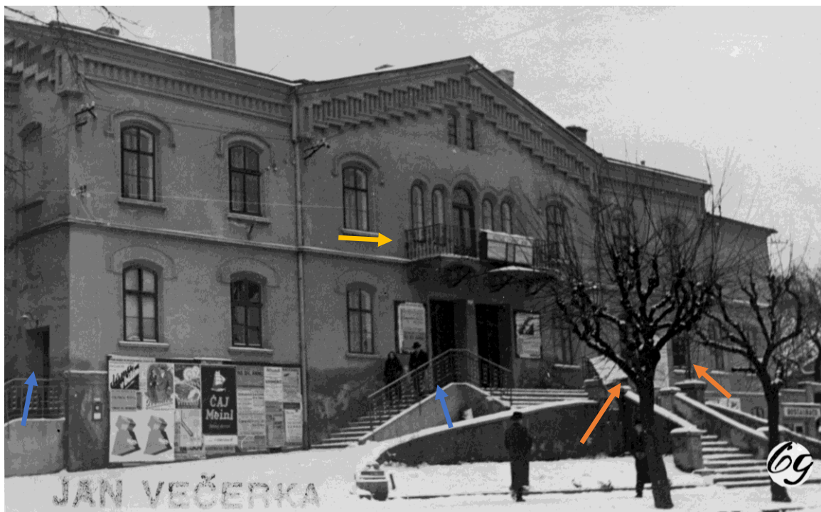
1935 dobová podoba průčelí se vstupem do objektu s kovovým balkonem v patře (žlutá šipka) a kovovým zábradlím v přízemí (modrá šipka), lampy na dvou pilířích (oranžová šipka)
