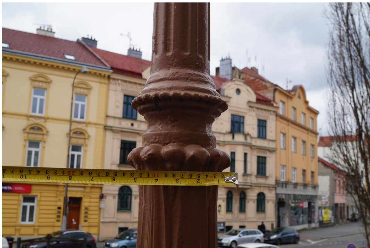
Celkový pohled na měření sloupu (střední část) s profilací rozvinuté rozety
