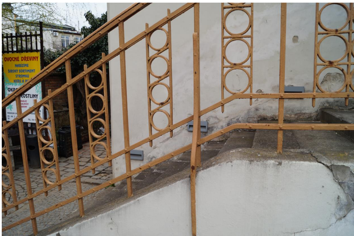
Celkový pohled na první rameno schodištního vstupu do objektu s konzolovou lampou
