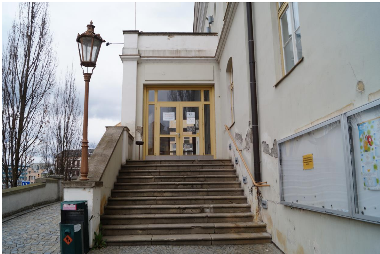
Celkový pohled na první rameno schodištního vstupu do objektu s konzolovou lampou
