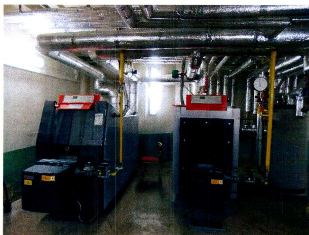
Kotel Viessmann VITOPLEX 300 má rok výroby 2004 a kotel Viadrus G700 má rok výroby 2009 (tentot kotel je náhrada za původní kondenzační kotel Viessmann VITOCROSSAL 300, kde došlo k proděravění kotlového tělesa vlivem špatné kvality topné vody).
