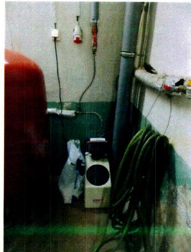
V kotelně je instalováno čerpadlové expanzní zařízení Reflex typu Variotec V1 – tlaková expanzní nádoba s membránou o velikosti 300 litrů, s doplňovacím čerpadlem a přepouštěcími ventily, které zajišťuje doplňování a odplynování topné vody. Na výstupním potrubí kotlů jsou umístěny pojistné ventily.
