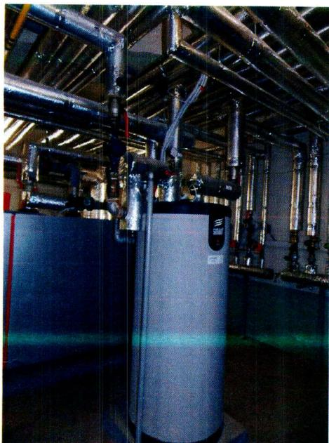
Mimo rozdělovač je přímo z kotlového okruhu napojen ohřev TV. Dle sdělení provozovatel není nyní ohřev vody využíván, ala má být zachován. Z ohřívačů teplé vody je rozvod vody připojen na rozdělovač TV a sběrač cirkulace TV.
