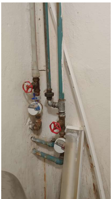
Obrázek 4 stávající podružní vodoměrné sestavy v místnosti 107
