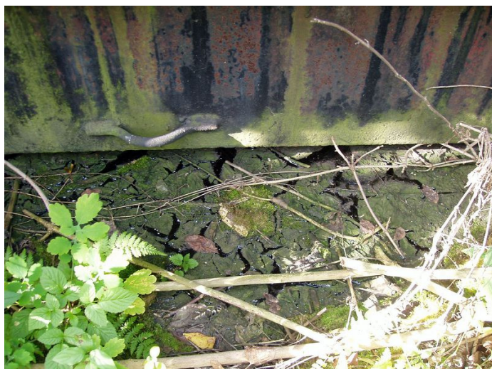
Obr. 6: Vrstva ropných látek pod nádrží (říjen 2012)
