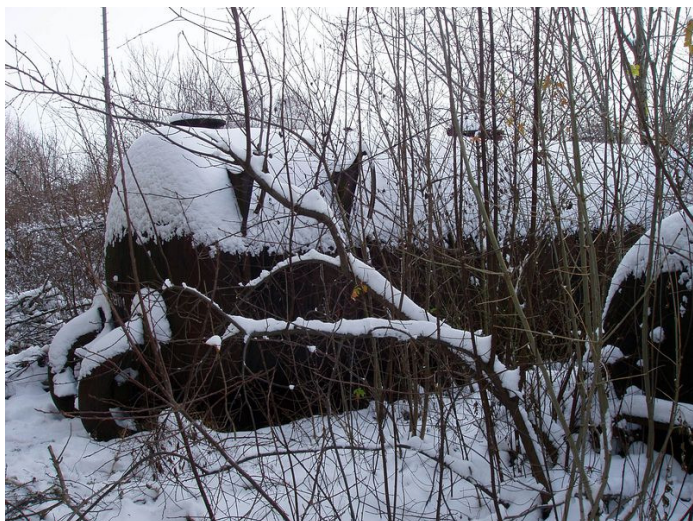
Obr. 3: Východní nádrž ze SZ
