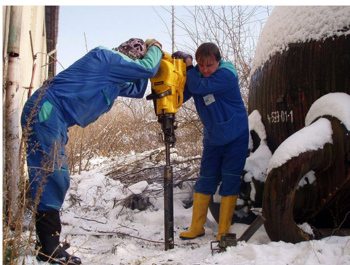
Obr. 7: Hloubení sondy S2
