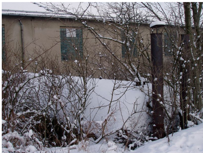
Obr. 4: Východní nádrž z JZ
