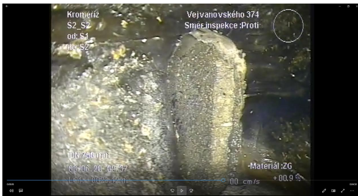
Detail vyústění dom. přípojky
