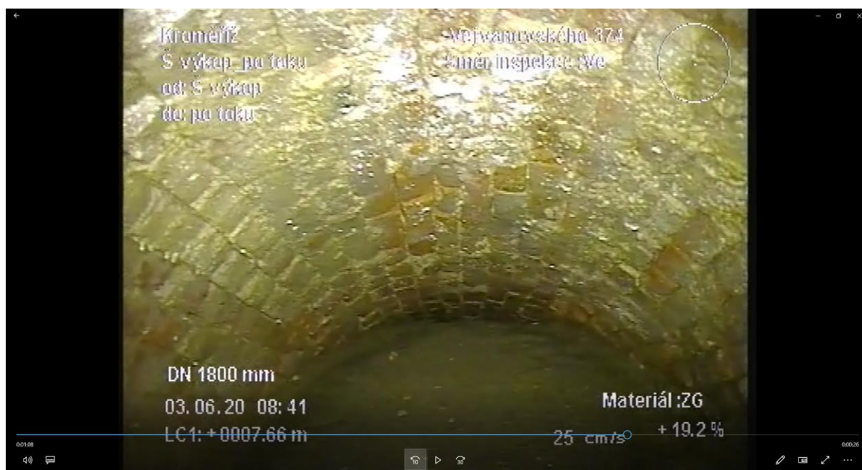
Detail ukončujícího závalu směrem k Moravě
