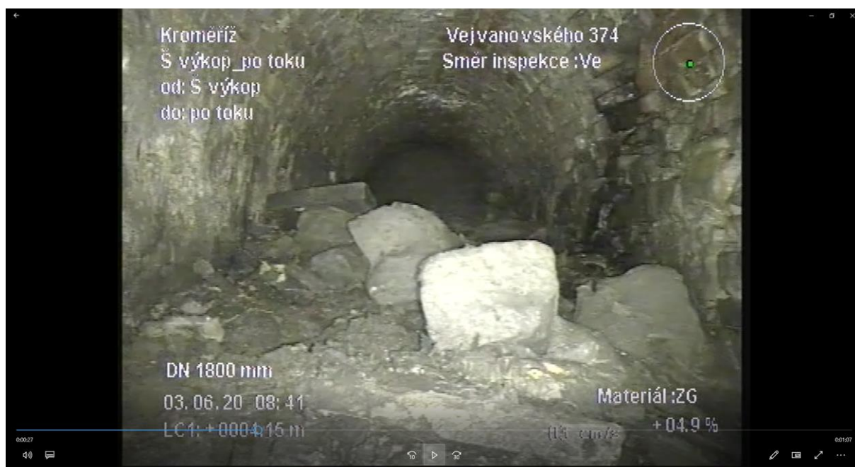
Bližší pohled , detail dalšího lokálního závalu směrem k Moravě
