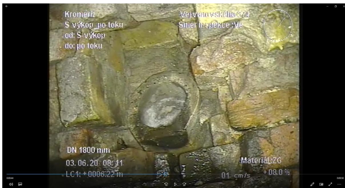
Detail vyústění dešťového kan. svodu.
