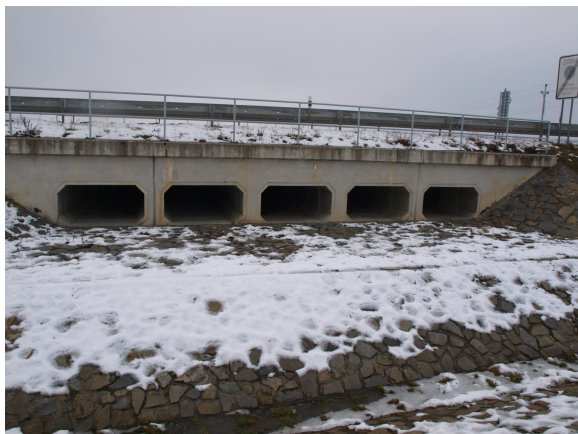
Propustek pod silnicí III/4327 - dálniční exit, Těleso silnice zde bude přeléváno
