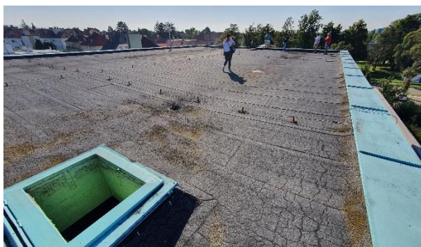
Popis: pohled na střechu č.1 – navrhovaná výměna asfaltových pásů
