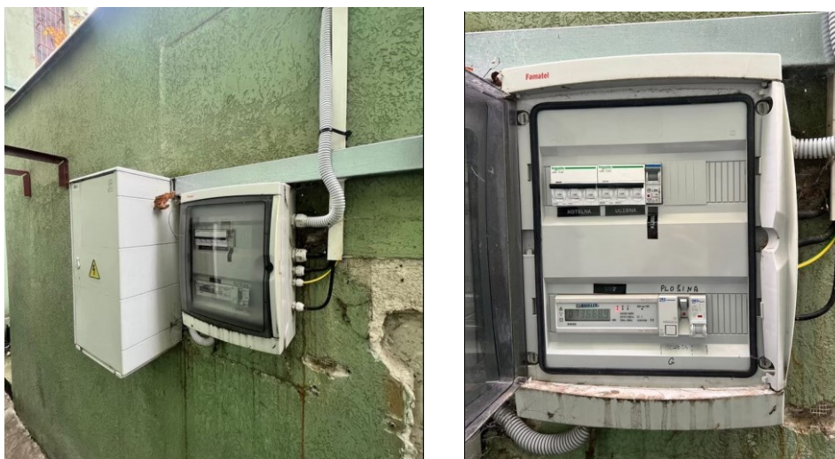
Obr. 1 – Rozvaděč pro napájení rozvaděče závlahového čerpadla
