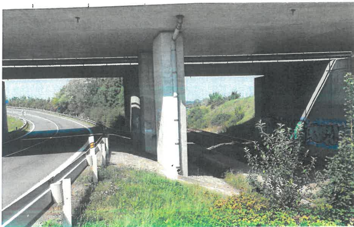
Obrázek 7 – Sil. II/367, podjezd pod mostem na D1, souběžná železniční trať
